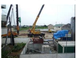
旧体育館の基礎となった杭抜きが終了し、新しい杭を打ち込むための準備が進められています。今月末までには杭の打ち込みが終了し、江田組による建設工事がはじまります。
