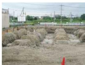
打ち込んだ杭の頭を出し、基礎・土台づくりを行っています。コンクリートを流し込む準備です。削り取られた土砂をダンプカーで運び出しています。
